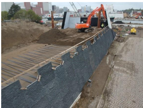
Mechanisch stabilisierter Erdwall, Bauphase
